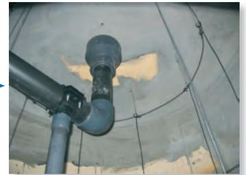
← 3. Une électrode de mesure
