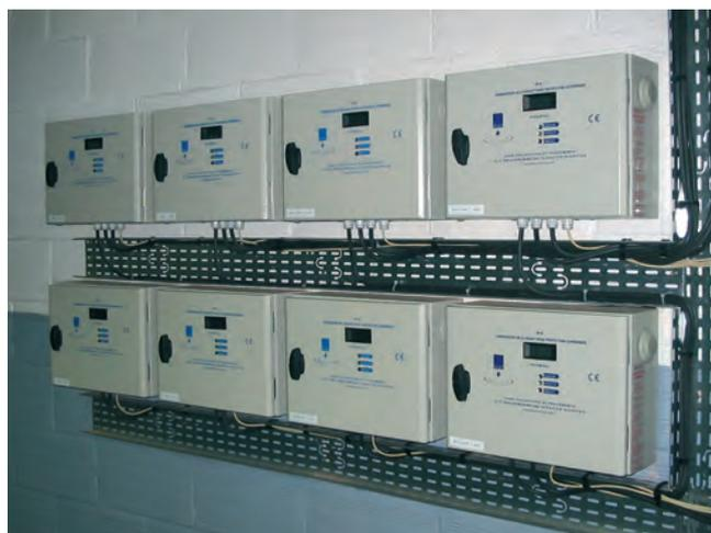
Cette électrode mesure en permanence la différence de potentiel entre l'ouvrage à protéger et l'eau ; ainsi, compte tenu de l'activation du potentiel souhaité, le générateur de courant continu libérera l'ampérage nécessaire et suffisant au maintien permanent du potentiel d'immunité de la pièce à protéger.
